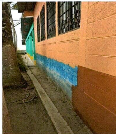
Foto 4: PINTURA DE AULAS
