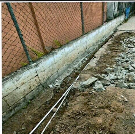
Foto 3: REPARACIÓN DE RED DE DRENAJES Y AGUA POTABLE
