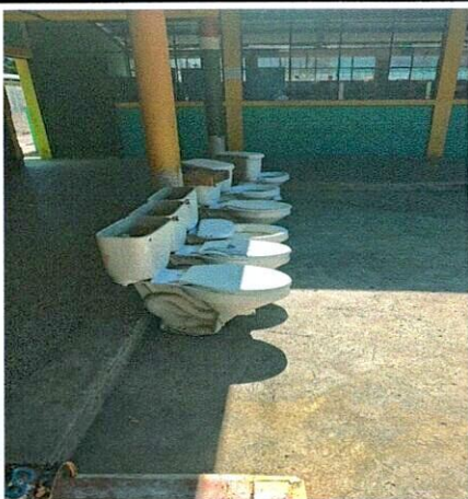
Foto 3: CAMBIO DE SANITARIOS
