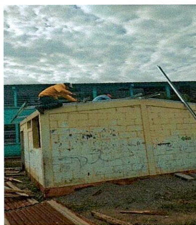
Foto 2: CAMBIO ESTRUCTURA Y LAMINA BODEGA
