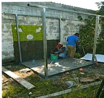
Foto 2: COLOCACIÓN DE PILA EN LA PARTE DE ATRÁS DE LA ESCUELA
