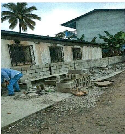
Foto1: REMOZAMIENTO MURO PERIMETRAL LADO SUR
