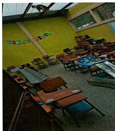
Foto 4: CAMBIO DE LAMINA EN UNA AULA DE LA PARTE FRONTAL DEL ESTABLECIMIENTO
